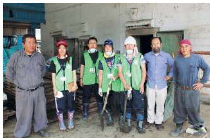
写真. 石巻市で被災した魚の加工場でのヘドロ除去作業。駆けつけてくれた高橋一先生(右から二番目)と。
