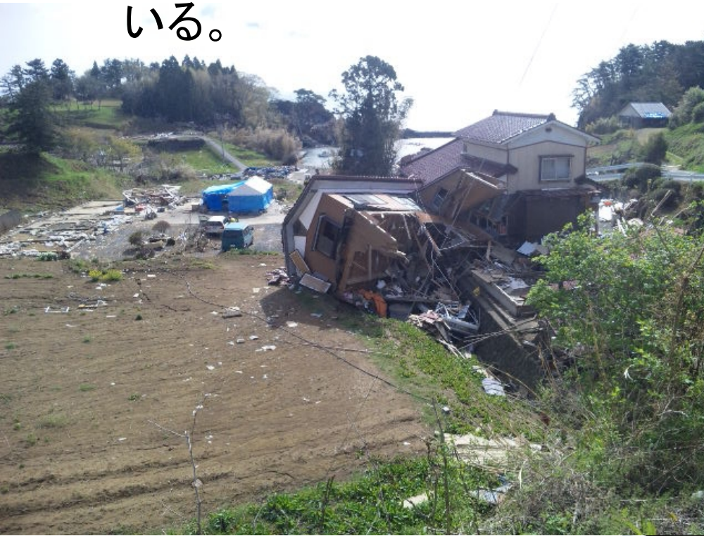
↑ 津波でなぎ倒された家
